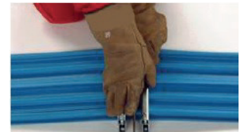
8 APRETAR PARA TERMOFUSION
